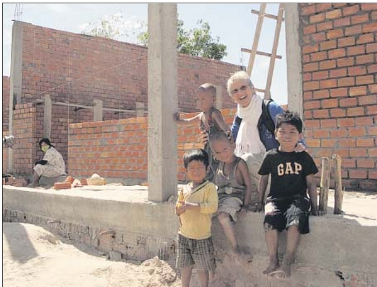
Ange Dries-Behrenbeck mit Kindern des Dorfes Khnar Village im Rohbau ihrer neuen Schule. Es ist bereits die zweite Schule, die die Bergedorferin zusammen mit ihrem Verein „Children's Dream“ in Kambodscha baut.
